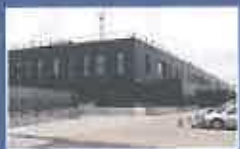
Cantonnement de CRS à Méaux
