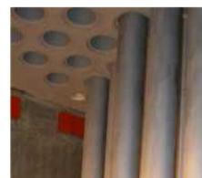
Figure 18 : Photo des puits de l'entreposage MVDS du site nucléaire de Paks (Hongrie)
