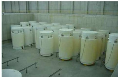
Figure 40 : Photo de TN<sup>®</sup>24 DH entreposés dans le bâtiment d'entreposage à sec du site de Doel (Belgique)
