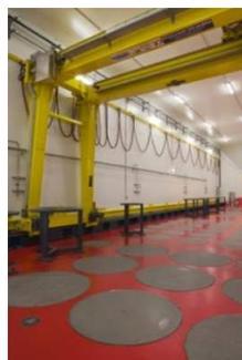
Figure 61 : Photo du sommet des puits d'entreposage de l'installation HABOG (Borsele - Pays-Bas)
