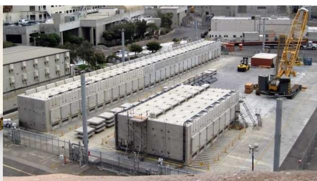
Figure 22 : Photo d'un entreposage de type modules NUHOMS<sup>®</sup> sur le site de San Onofre (États-Unis)
