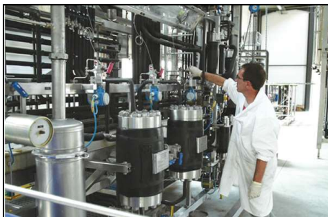
Installation d’extraction aux fluides supercritiques située dans le Vaucluse.
